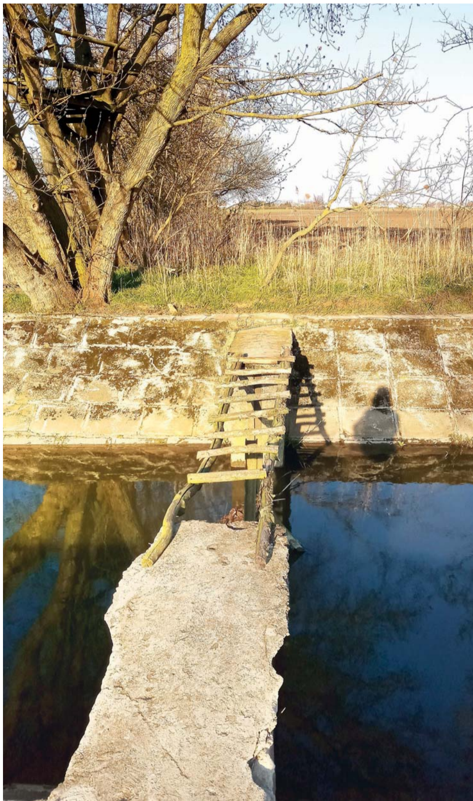
Někdy je potřeba důvěřovat, že mě lávka udrží.
